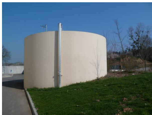
Silo de stockage des boues en attente de traitement
