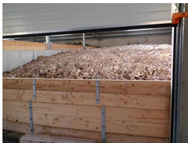
Stockage des boues avant épandage
