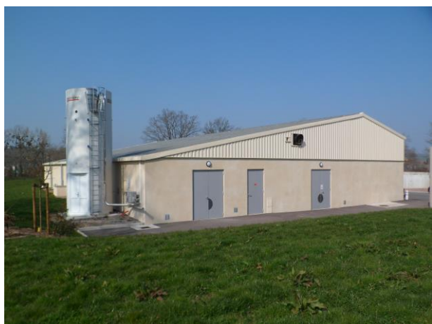
Vue d'ensemble du site de traitement des boues
